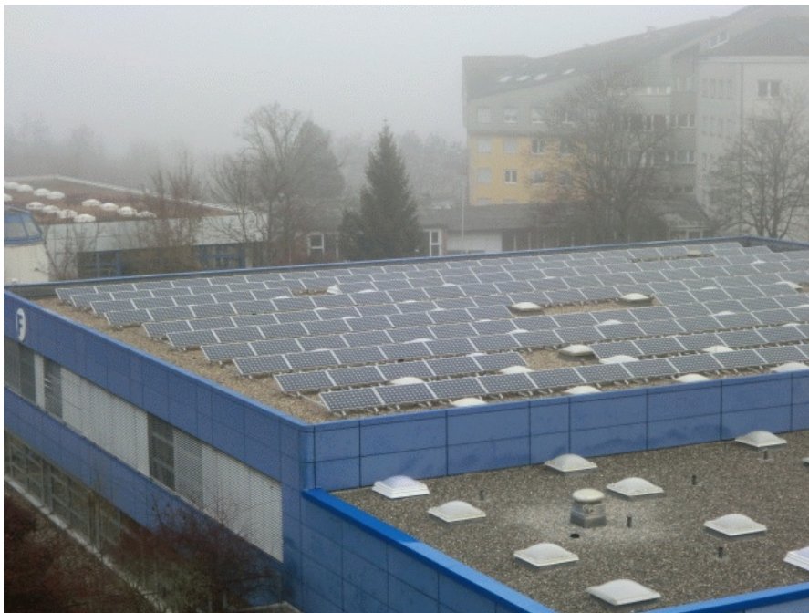
Quelle: eigenes Bild. Es zeigt die Photovoltaik-Anlage des BSZ.
